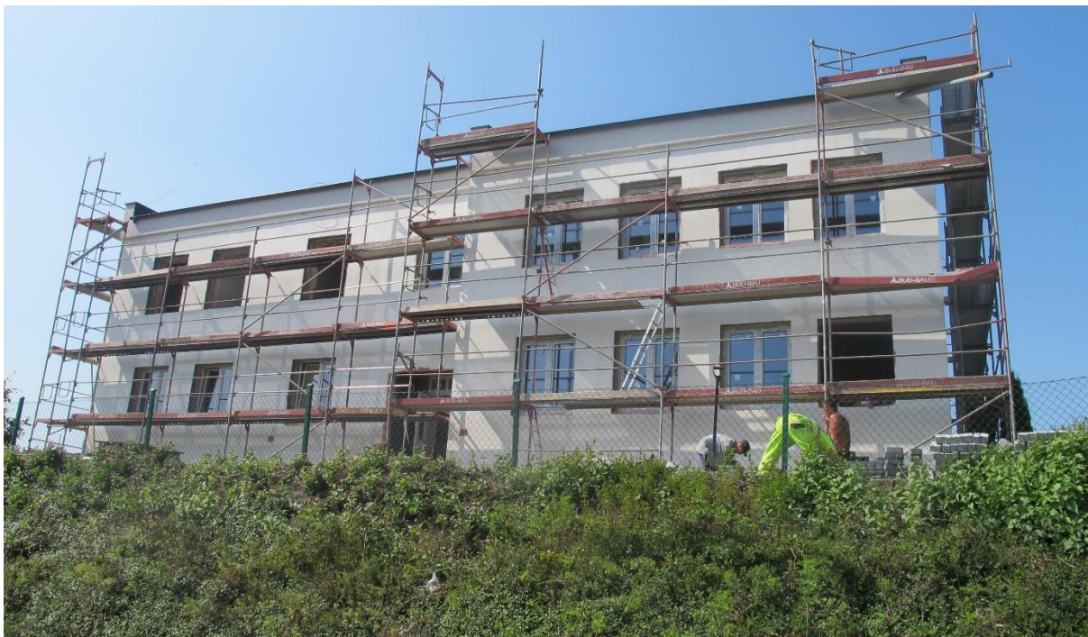
Budynek Szkoły Podstawowej w Szarłacie w trakcie termomodernizacji
