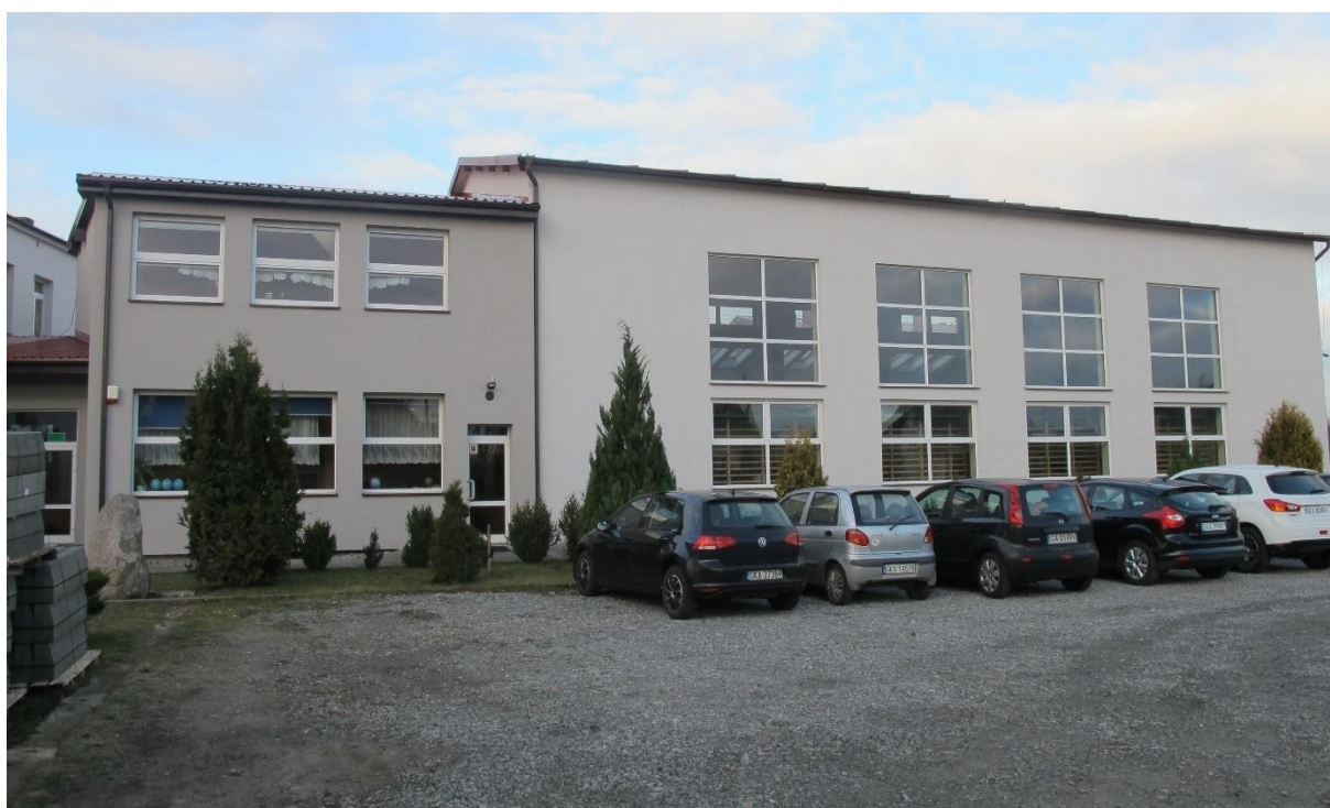
Rozbudowa Szkoły Podstawowej w Pomieczynie
