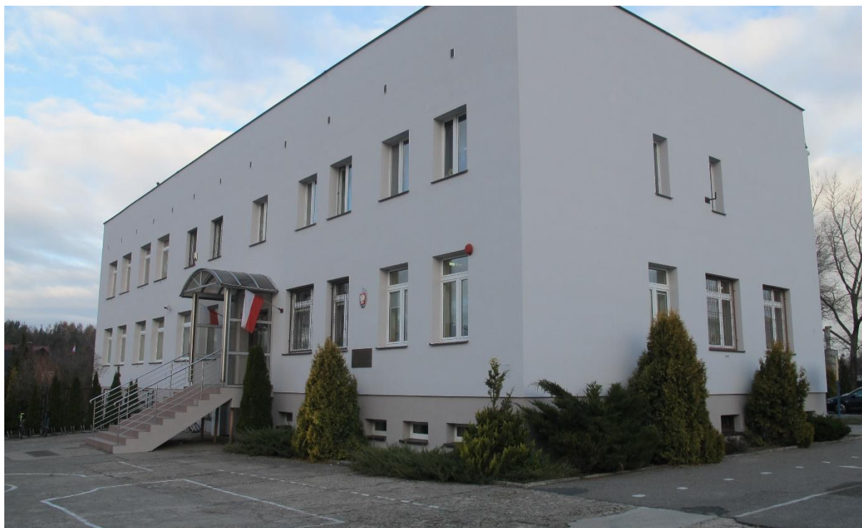
Rozbudowa Szkoły Podstawowej w Pomieczynie
