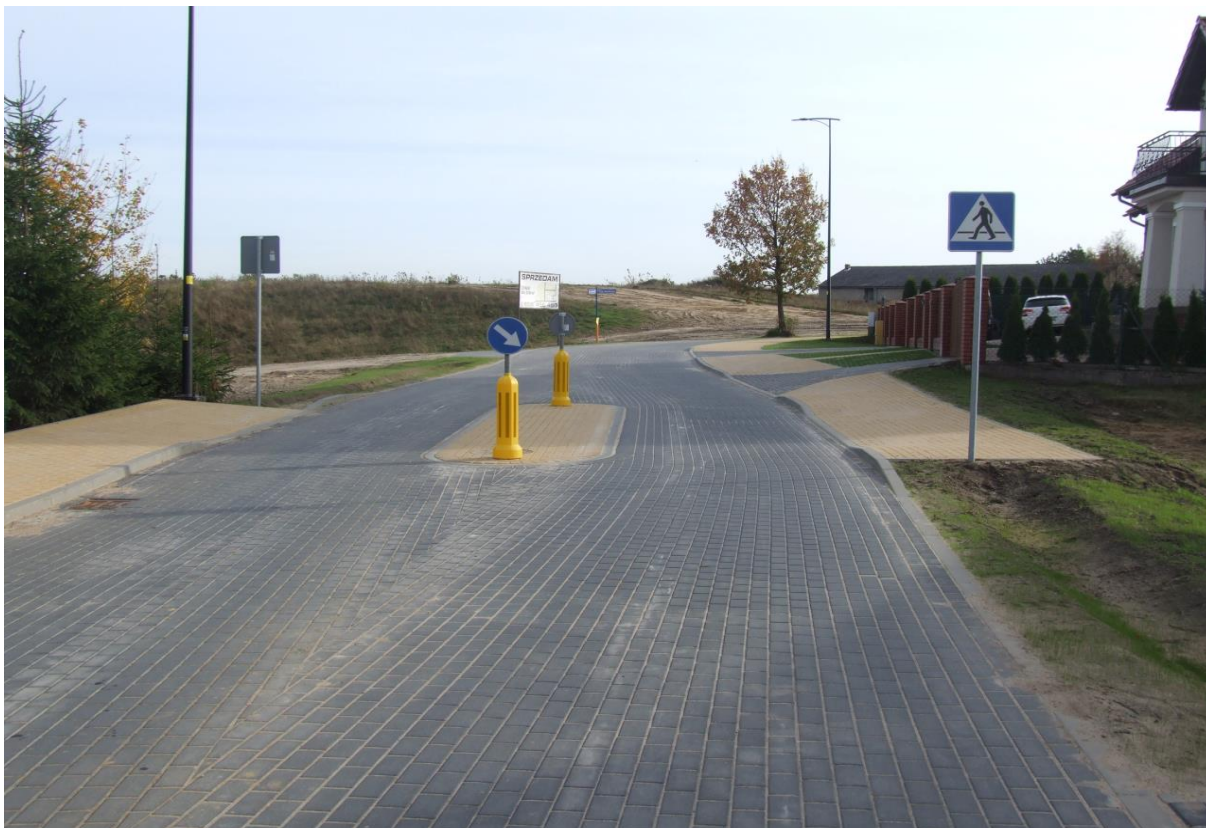
Modernizacja drogi gminnej w Kobysewie
