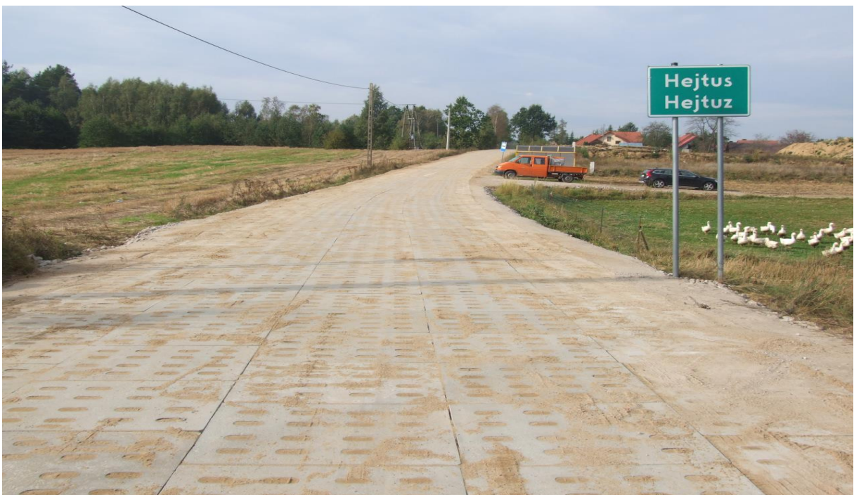
Modernizacja drogi w Hejtusie
