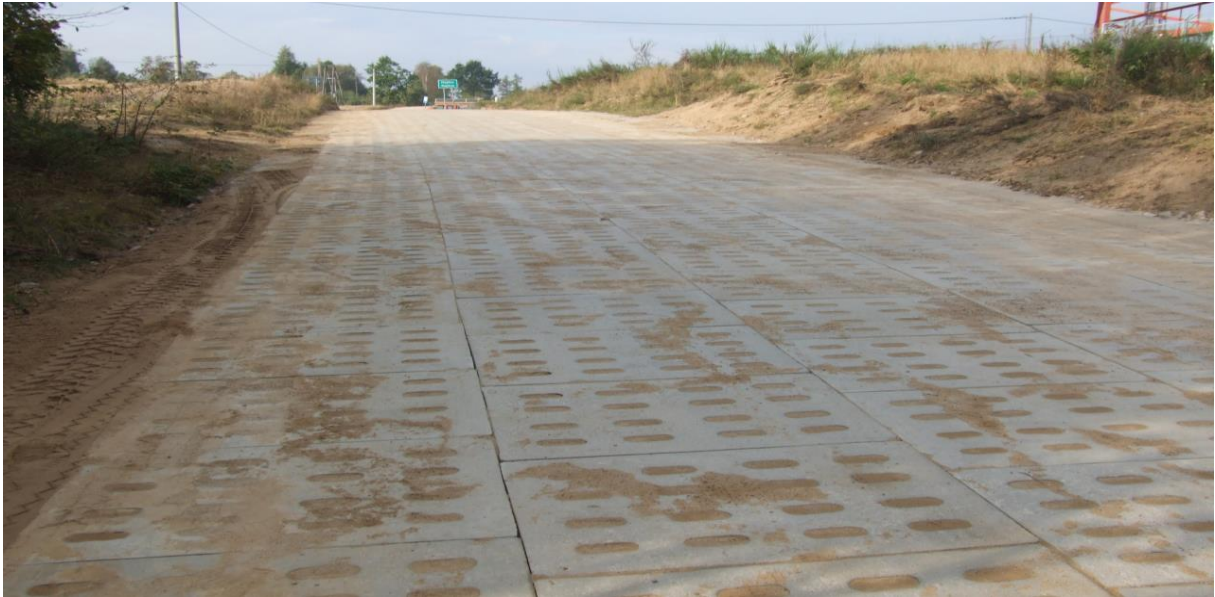
Modernizacja drogi w Hejtusie
