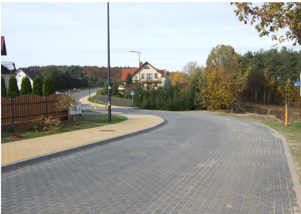
Modernizacja drogi gminnej w Kobysewie
