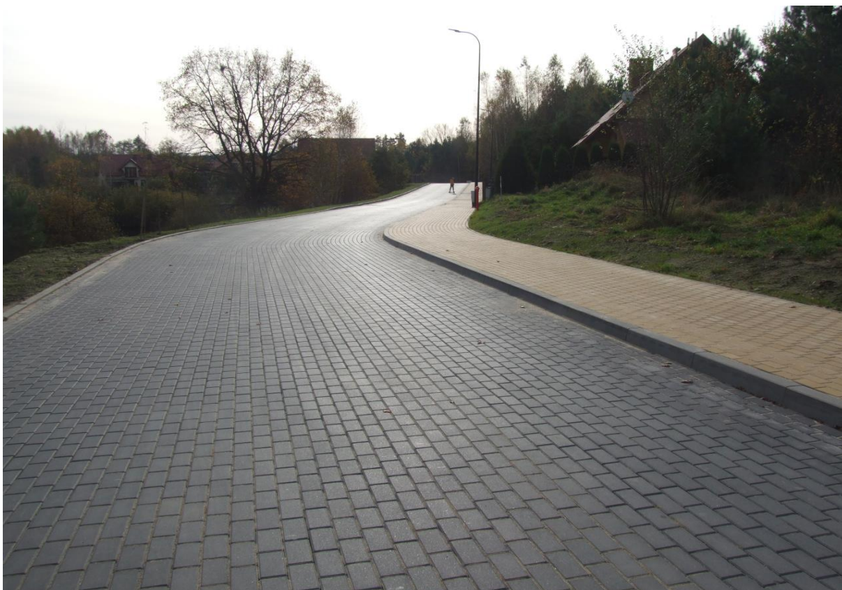
Modernizacja drogi gminnej w Kobysewie
