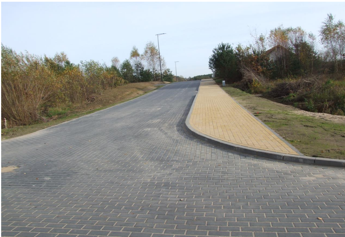
Modernizacja drogi gminnej w Kobysewie
