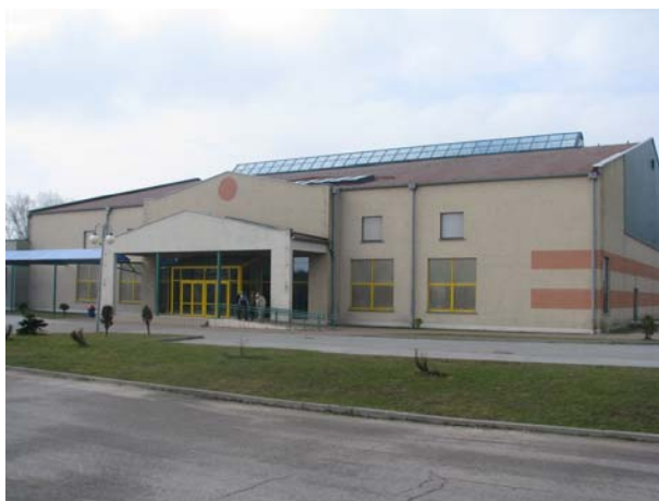
Rys 9. Hala sportowo – widowiskowa w Przodkowie. Źródło: Autor.
