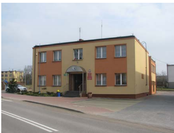
Rys 10. Budynek Urzędu Gminy Przodkowo.
