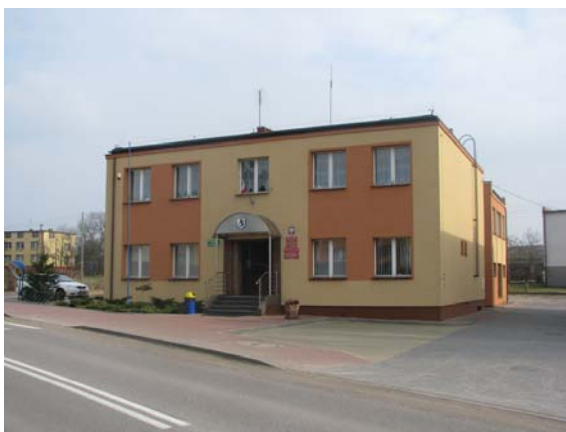
Rys 10. Budynek Urzędu Gminy Przodkowo.
